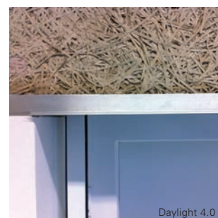
Überdeckung der Baukörperanschlussfuge
