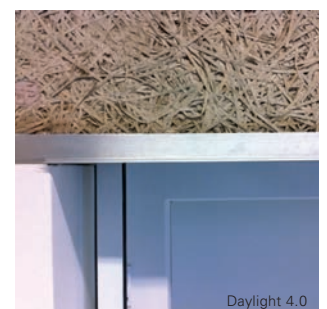
Überdeckung der Baukörperanschlussfuge
